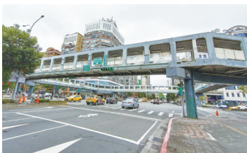
▲ 近年來行人天橋已所剩無幾。圖為和平新生人行天橋。該橋現已拆除。(photo by 臺灣戲劇取景地點 Taiwan Drama Location via Facebook)
