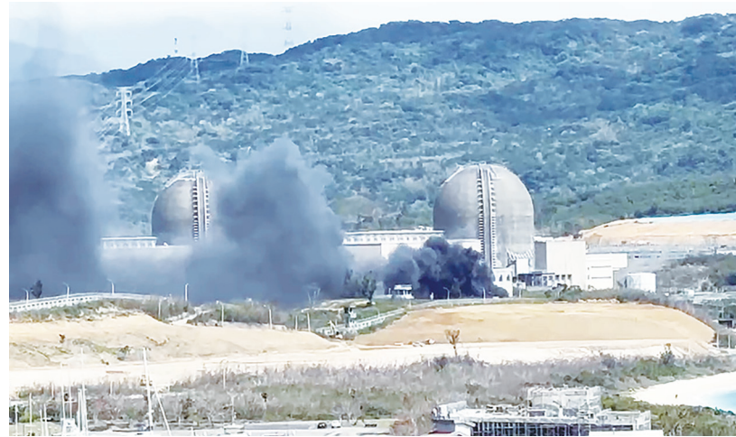
▲ 屏東恆春台電核三廠 6 日上午突冒黑煙，屏東縣消防局回報表示，現場為廢棄空壓機廠房後方 2 座冷卻水塔起火，火勢已熄滅、無安全疑慮。（中央社）
