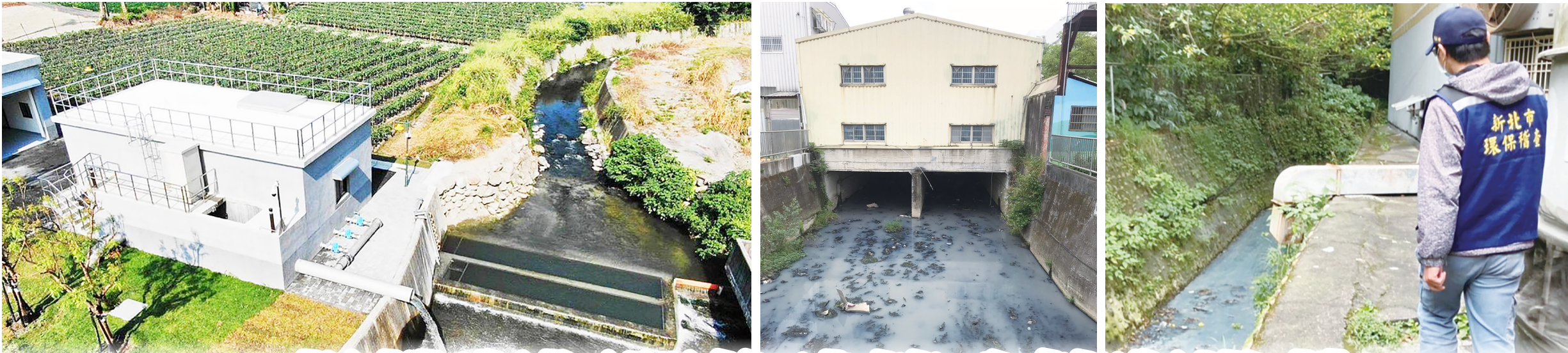
▲環保局成立環境稽查重案組，嚴加取締溪水旁的違章建築污染源頭。(新北市環境保護局提供)
