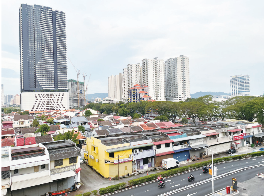
▲全球供應鏈重組，馬來西亞成為國際大廠布局樞紐，除了半導體、電機電子、智慧物流、伺服器、資料中心、雲端軟體服務等新興產業紛紛擴點。圖為檳城市區新舊建築交錯林立。
