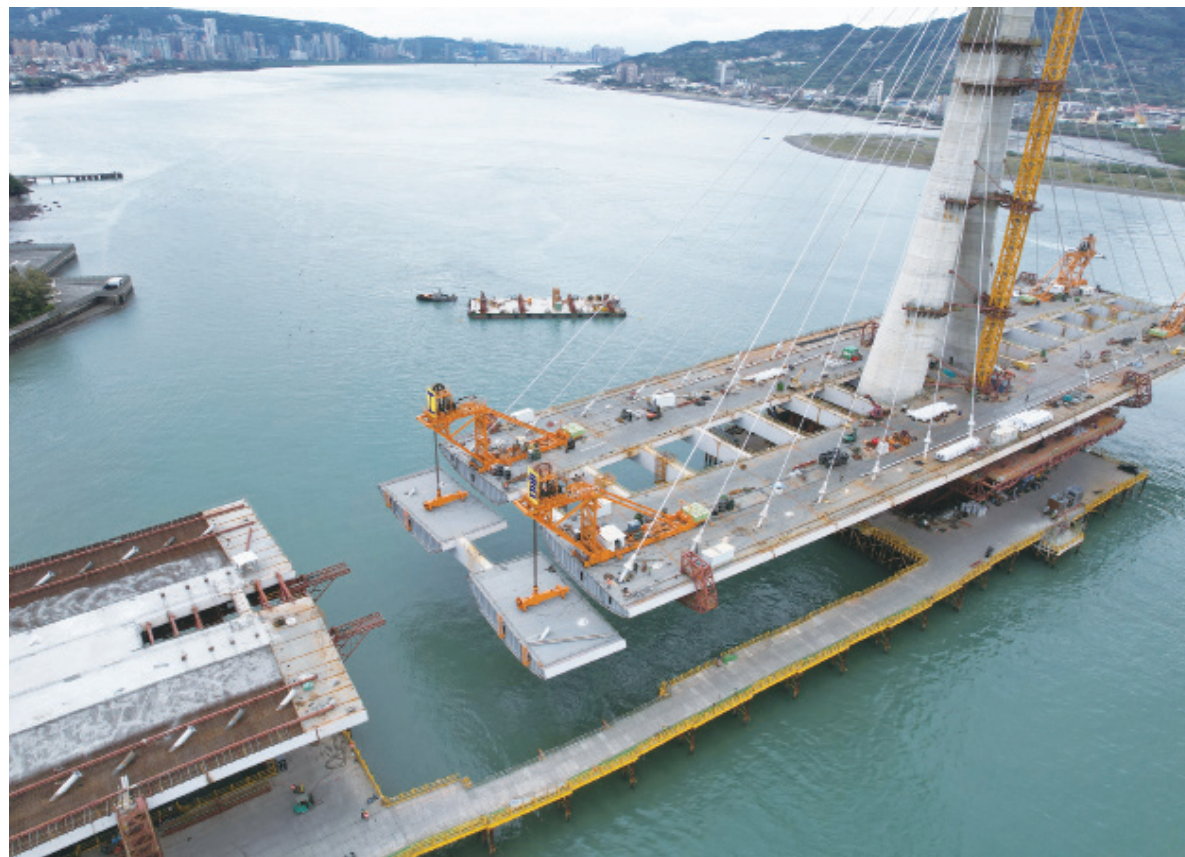
▲ 淡江大橋第 3 標主橋段工程 19 日懸臂吊 7T 鋼梁節塊，相關單位日前表示，預計淡水端 3 月合攏。
