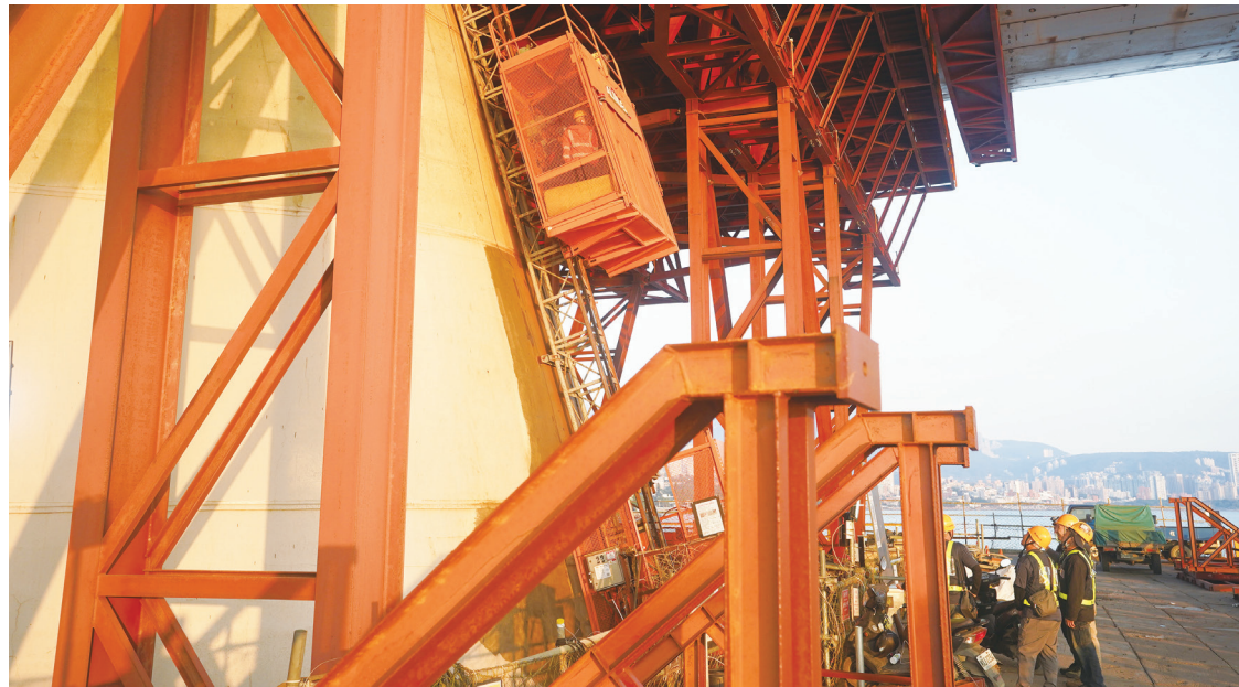
▲ 淡江大橋預計 114 年底完工，115 年 3 月通車。站在淡江大橋主橋體上，可以看到傍晚夕陽西下，滿天橘紅，橋塔配合落日位置。圖為施工人員排隊搭乘工程電梯。
