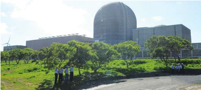
▲核三廠2號機已依大修計畫完成反應爐冷卻水系統、安全系統與主汽機發電機等相關設備維護檢查，以及核燃料更換、反應爐螺樁修復等作業。（中央社）
