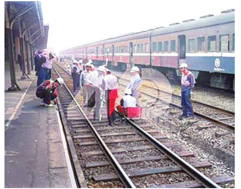
▲鐵路電氣化工程開始作實地測量情形。(中央社)
