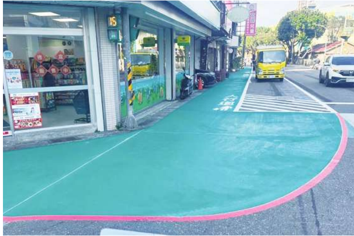
▲ 桃園市政府「人本友善 168」計畫，透過行穿線退縮、人車動線分流及路型調整等交通工程手段，提高行人穿越馬路安全性。(中央社)
