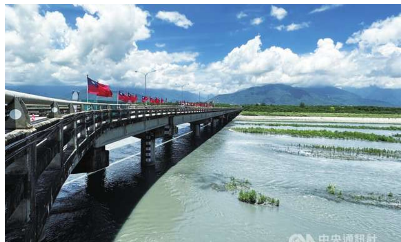
▲ 連接縱谷與海線的花蓮大橋，位於嶺頂斷層地質敏感區，歷經0206大地震橋梁位移，考量安全交通部斥資近24億元重建，預計115年完工。（中央社）
