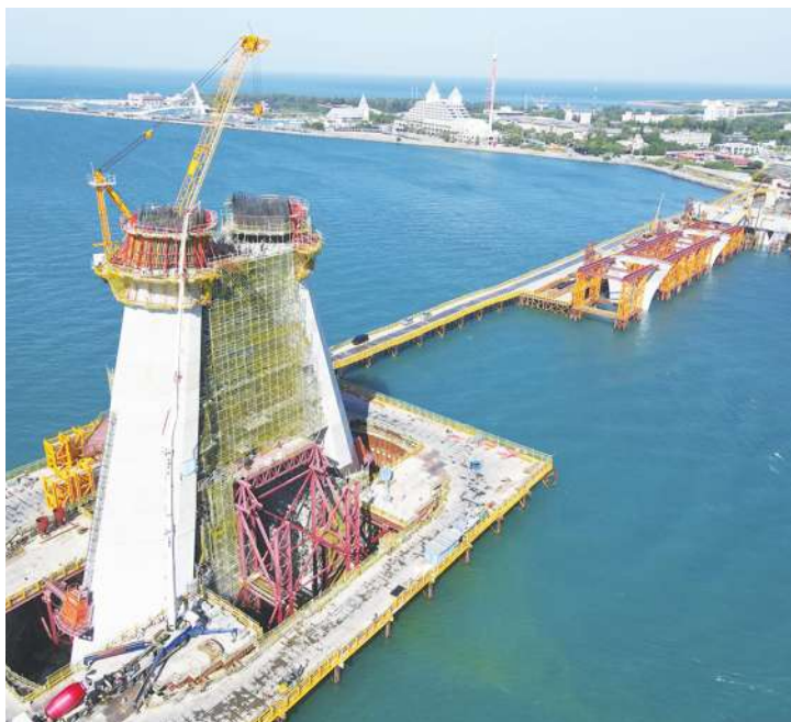
▲位於新北市淡水區與八里區交界的淡江大橋，全長約6公里，將來北端可以串連台2線、銜接淡北道路。圖為28日主橋塔往淡水端的施工進度。
