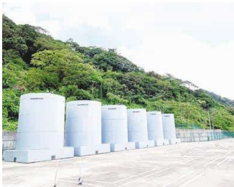
◀ 圖為核一廠露天核廢料乾貯場。（台電提供）
