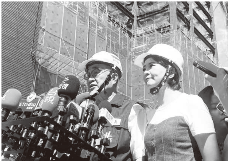
▲ 基泰建設施工不慎造成台北市大直街民宅下陷，在完成相關前置作業後，26 日上午執行 25 戶拆除作業，台北市副市長李四川(左)受訪表示，盼 10 天內拆完，28 日說明會將討論是否公辦都更。
