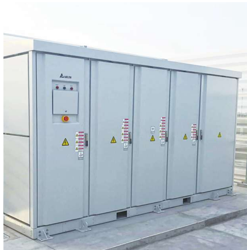
▲ 台達電為彰濱光電場量身設計的戶外型功率調節系統與開放式儲能貨櫃。（網路截圖）
