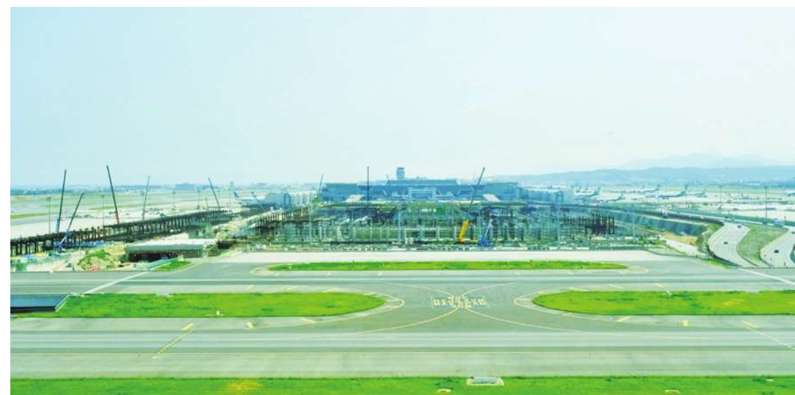
▲行政院副院長鄭文燦 2 日前往視察第 3 航站區主體航廈土建工程，指出現在第 3 航廈整體進度已達 46%，這也是國內單一建築最大工程，預定在民國 113 年完成北登機廊廳、114 年完成航廈主體工程、115 年完成南登機廊廳。（中央社）
