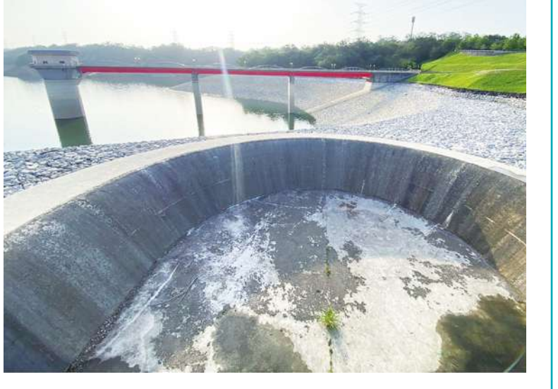
▲新竹地區水情燈號轉為黃燈，目前寶二水庫與寶山水庫合計蓄水量僅約 38%，壩堤下礫石裸露。經濟部水利署北區水資源局 17 日表示，目前為枯水期尾聲，5 月將進入豐水期，預料將會有所改善。
