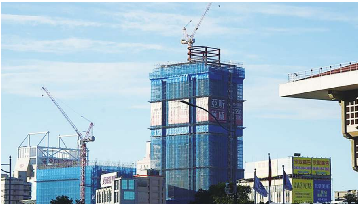
▲行政院消保處查核全國 50 項建案預售屋買賣契約發現，18 份契約共 55 項次不符合規定情節包含交屋保留款數不足、驗收次數僅限 1 次等 8 大樣態。(中央社)
