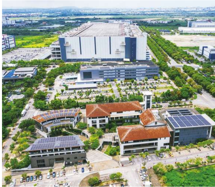
▲南部科學園區台南園區1、2期建廠用地使用率幾近滿載，也帶動周邊區域發展。圖為南科周邊區域空拍圖。
