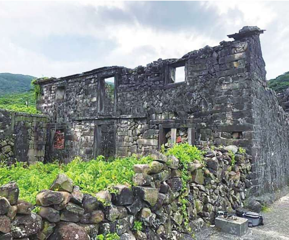
▲砌石工法與一般閩南聚落用石方法類似，採用平行砌、人字砌、亂石砌等。（網路截圖）
