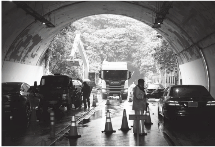
▲颱風尼莎帶來豪雨，內湖區康樂隧道口 16 日傍晚發生土石及路樹崩落，雙向無法通行；台北市新工處連夜趕工，17 日上午已搶通，並持續進行邊坡修復工作。
