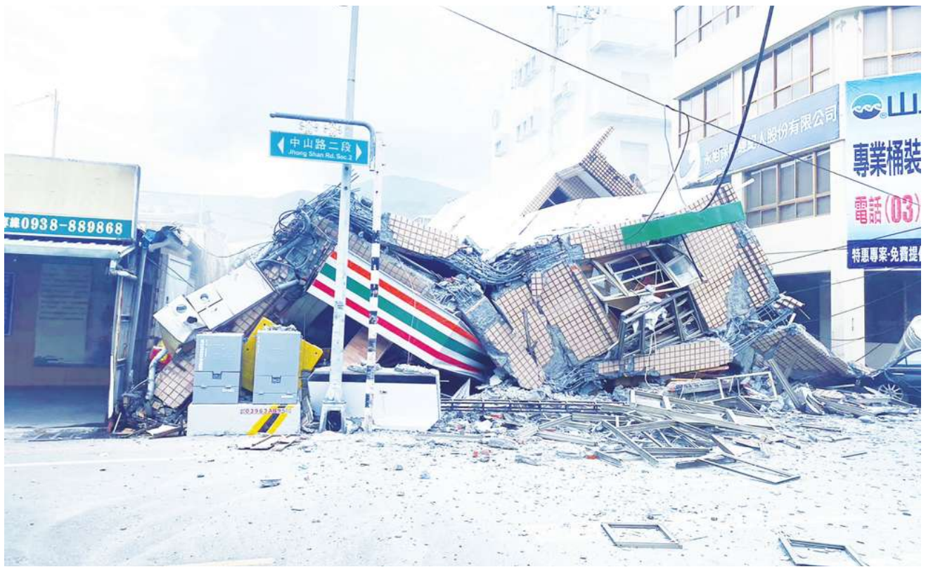
▲17日規模6.4強震襲擊台東，餘震不斷，18日下午2點44分更發生規模6.8的餘震，強度更超越17日的地震，上圖為花蓮玉里鎮的7-11超商倒塌。(民眾提供)
