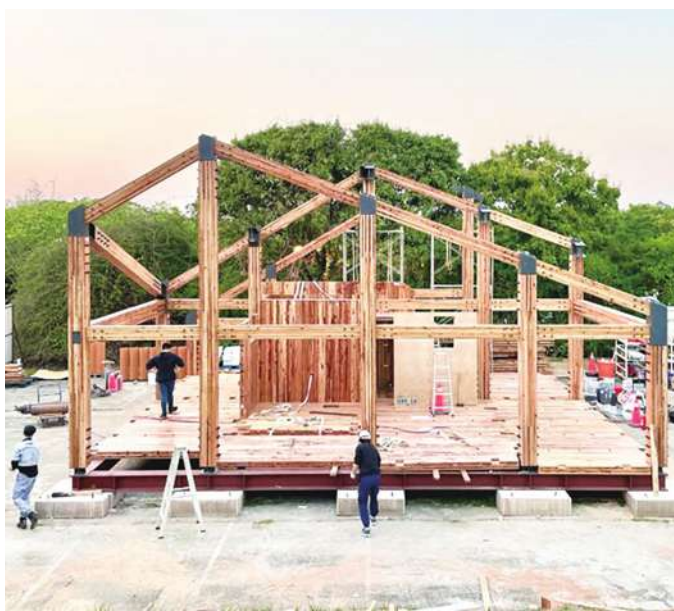
▲設計中心副主任、帶領學生到德國參賽的曾聖凱說，整個設計採用100%的CLT木造材料打造，在施工結構上以螺栓取代釘子，可重複拆卸組裝。(國立陽明交通大學提供)
