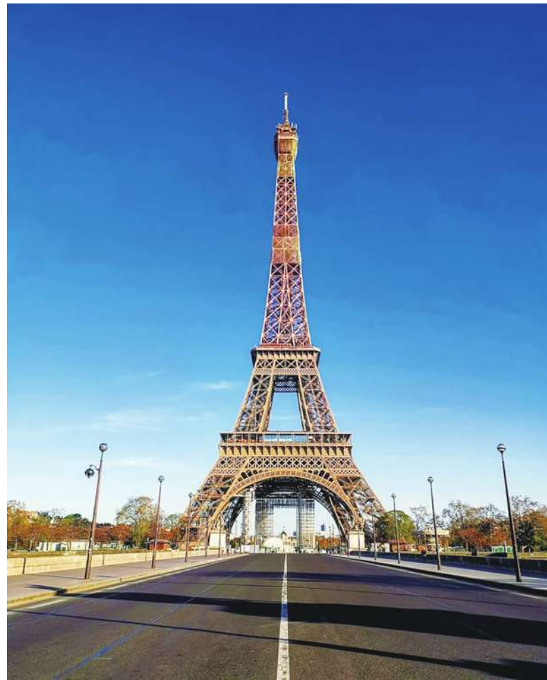
▲ 法國雜誌「瑪麗安娜」(Marianne) 引述機密報告報導，巴黎地標艾菲爾鐵塔 (Eiffel Tower) 鏽跡斑斑，需要全面整修，但在 2024 年巴黎奧運之前，只耗資 6000 萬歐元重新粉刷。
