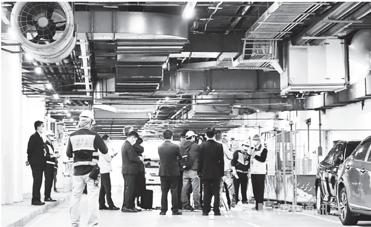
▲桃園國際機場第二航廈日前因電力設施遭人為破壞，導致跳電事故；立委呼籲交通部加強桃機管制，交通部也承諾會改善。（中央社）
