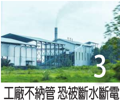
工廠不納管 恐被斷水斷電
