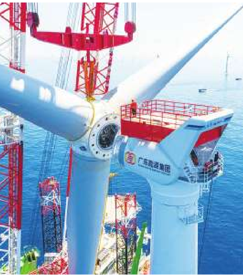
▲ 中國大陸也在減碳這方面做了一些承諾，所以需要朝這個方向來邁進。圖為 9 月 9 日，廣東省陽江市安裝一座大型風力發電機。(中央社)
