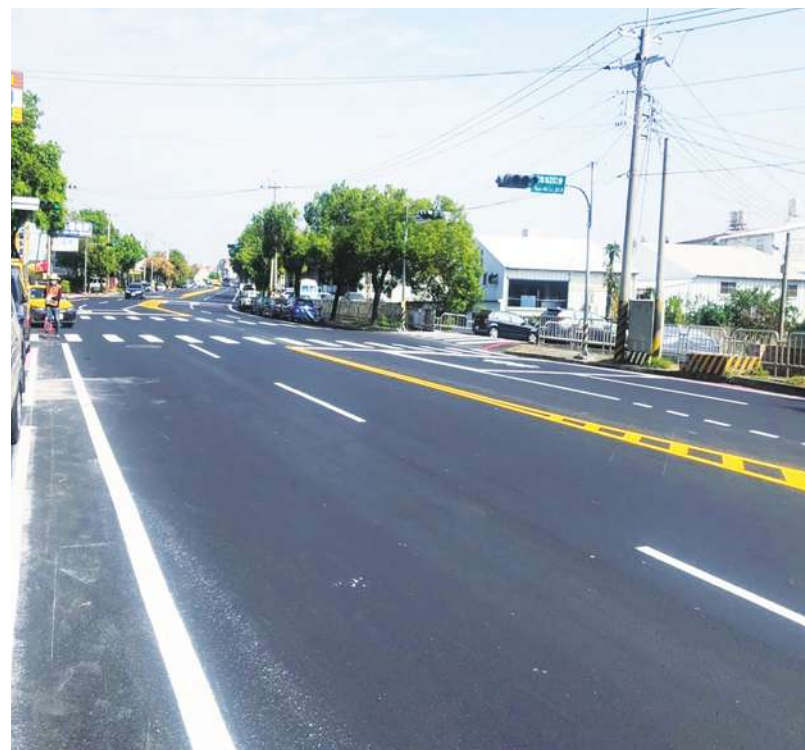
▲ 西屯區福雅路第二期工程。（Photo by 台中市政府）
