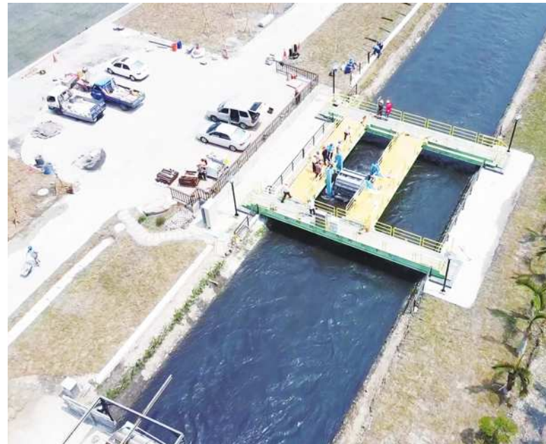
▲台電利用蘭陽電廠發電尾水打造全國首座流速型微水力測試平台，目前已訂定試驗服務條款，後續將尋求經濟部標檢局與能源局等協助，建立有效力的認證機制。
