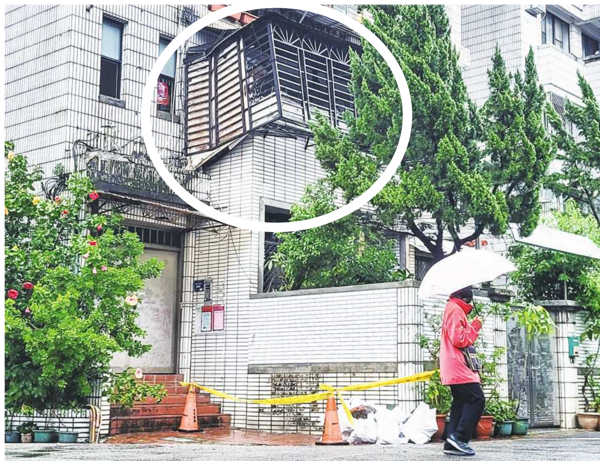
▲宜蘭縣南澳鄉24日下午發生芮氏規模6.5地震，全台有感，台北市文山區有民宅發生屋簷掉落、外牆剝落等狀況，現場已圍起封鎖線。(中央社)
