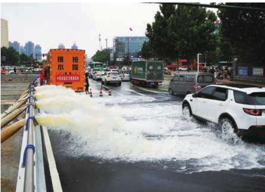
▲圖為22日，中國安能第二工程局攜帶「龍吸水」等救援裝備，在鄭州市京廣北路隧道由北往南展開抽排水作業。(中央社)
