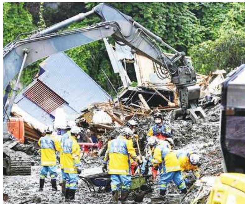
▲日本靜岡縣熱海市伊豆山地區的土石流浩劫累計 7 死，另有 27 人仍失聯待確認，警消與自衛隊徒手搬開大量泥土持續搜救工作。
