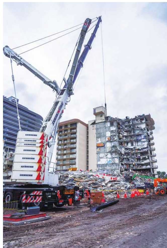
▲ 美國佛州一棟濱海公寓高樓 24 日坍塌，迄今已近一週，邁阿密戴德郡 (Miami-Dade County) 郡長萊文、卡瓦說：搜救人員又在瓦礫堆中尋獲 9 具遺體，死亡人數增至 18 人。
