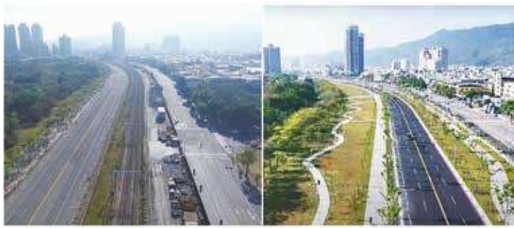
▲ 高雄市區鐵路地下化園道開闢前後工程照片。（明誠四路至美術館段）
