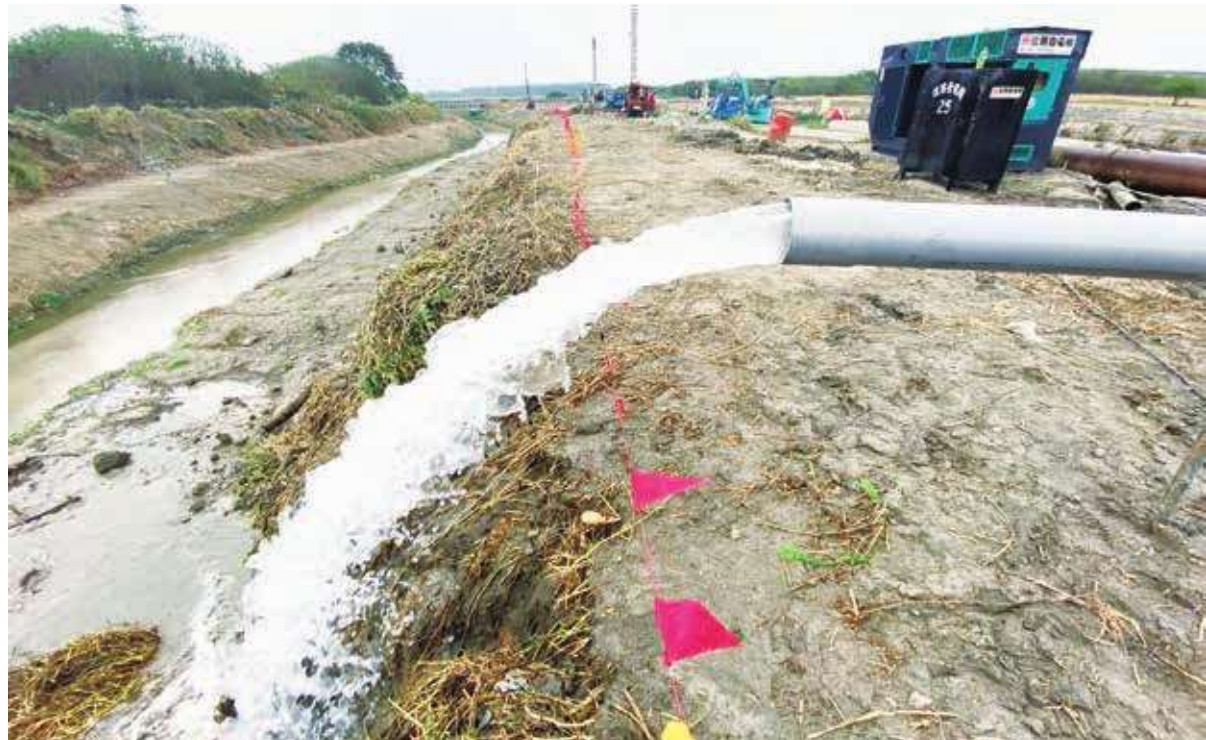
為穩定高雄市旱季供水，高雄市政府加速開鑿水井，將以每天逾一口速度，計劃於 4 月底完成 7 口水井的開發。圖為位於農水署九曲工作站的鑿井工程。(中央社)
