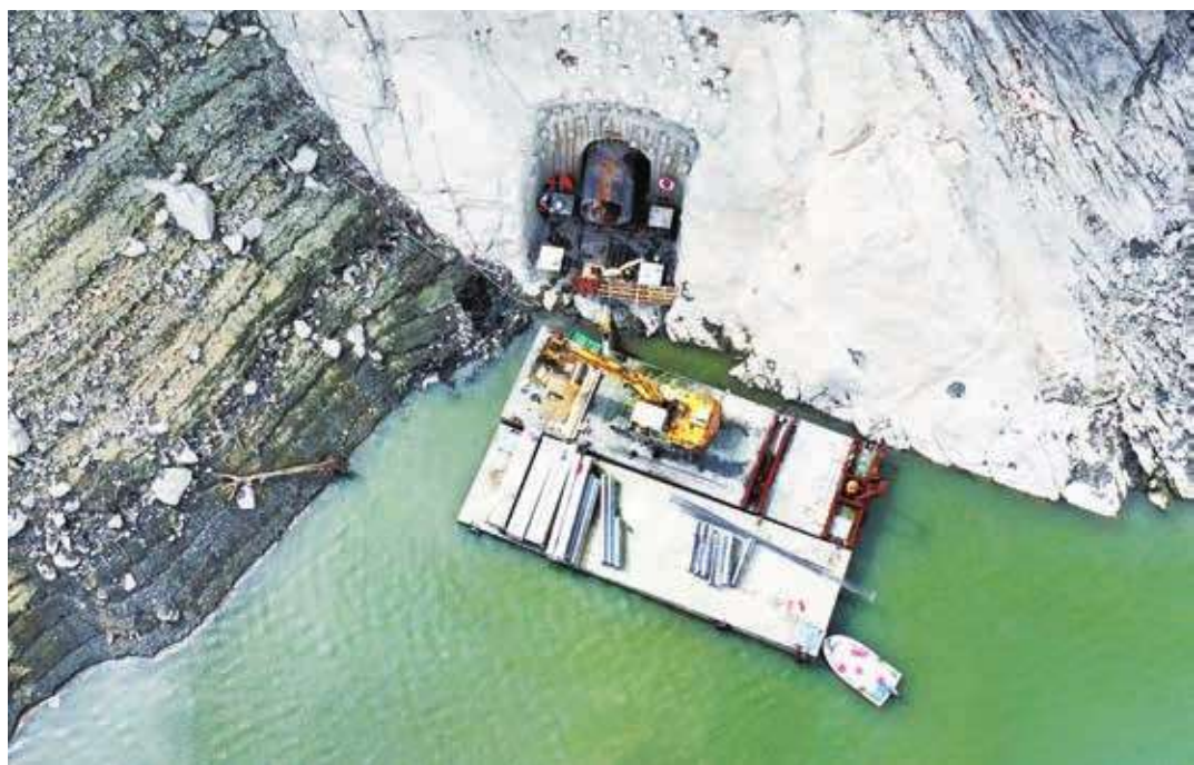
▲趁著石門水庫低水位，水利署北區水資源局從 23 日備妥施工機具進場作業，趕辦分層取水口下層取水口施工，預定 5 月底前完成，完工後將可讓水庫供水更加方便。(北區水資源局提供)
