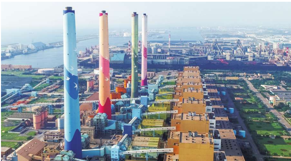
▲中火重啟3號機，盧秀燕重批中央不溝通、不協商，是惡意與民為敵！圖為台中環保局監控中火機組運作情形。(photo by 台中市新聞局)
