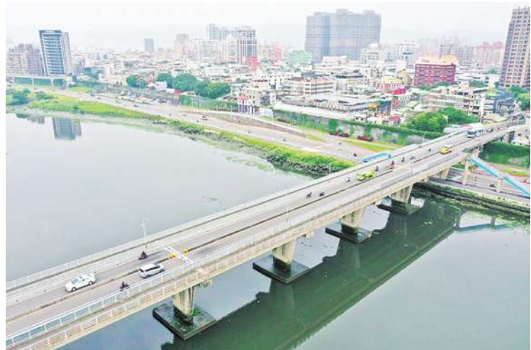
▲ 新海橋長期以來交通量大，經檢視伸縮縫已損耗必須更新，施工期間車輛請提前改道避免進入工區，以保障施工人員及用路人安全。(網路截圖)
