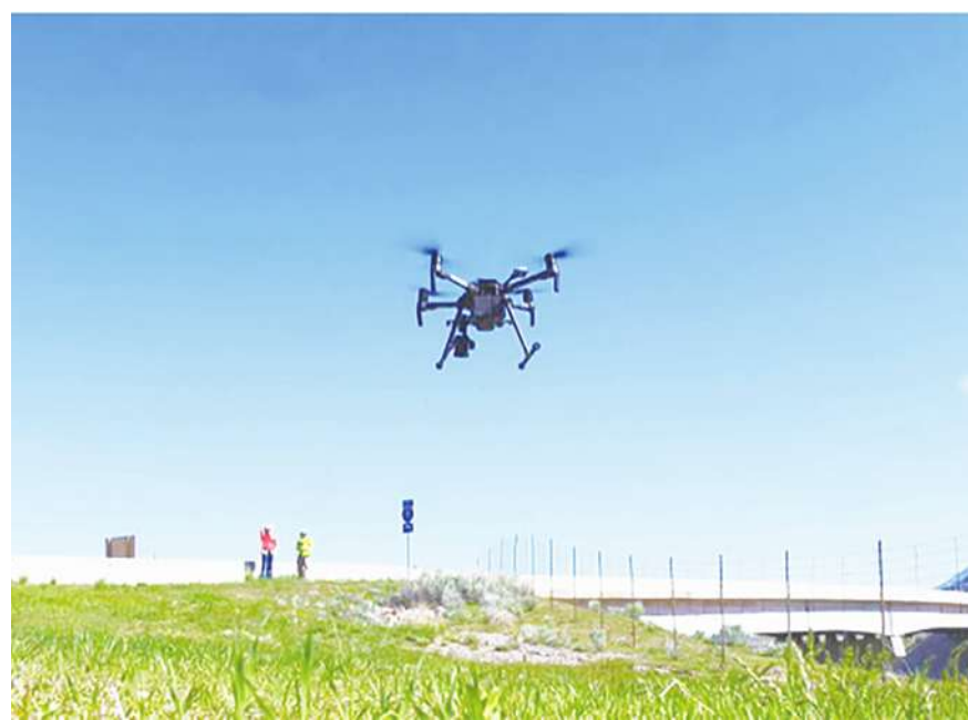
▲ 工程團隊利用無人機取代人工垂降考察，減少人員傷亡並獲得更精確的考察報告。(Photo from HDR)
