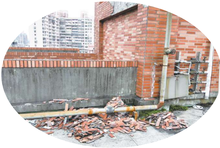
▲老一點的建築物一遇到寒流來襲，外牆的瓷磚就容易剝落而有砸到路人的問題。（網路截圖）
