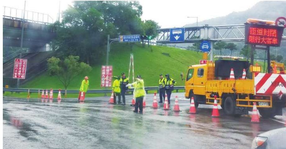
▲110年元旦連續假期將屆，國道5號石碇及坪林交流道南向入口匝道於1月1日至2日0時到中午12時實施封閉管制措施，籲請用路人提前改道。
