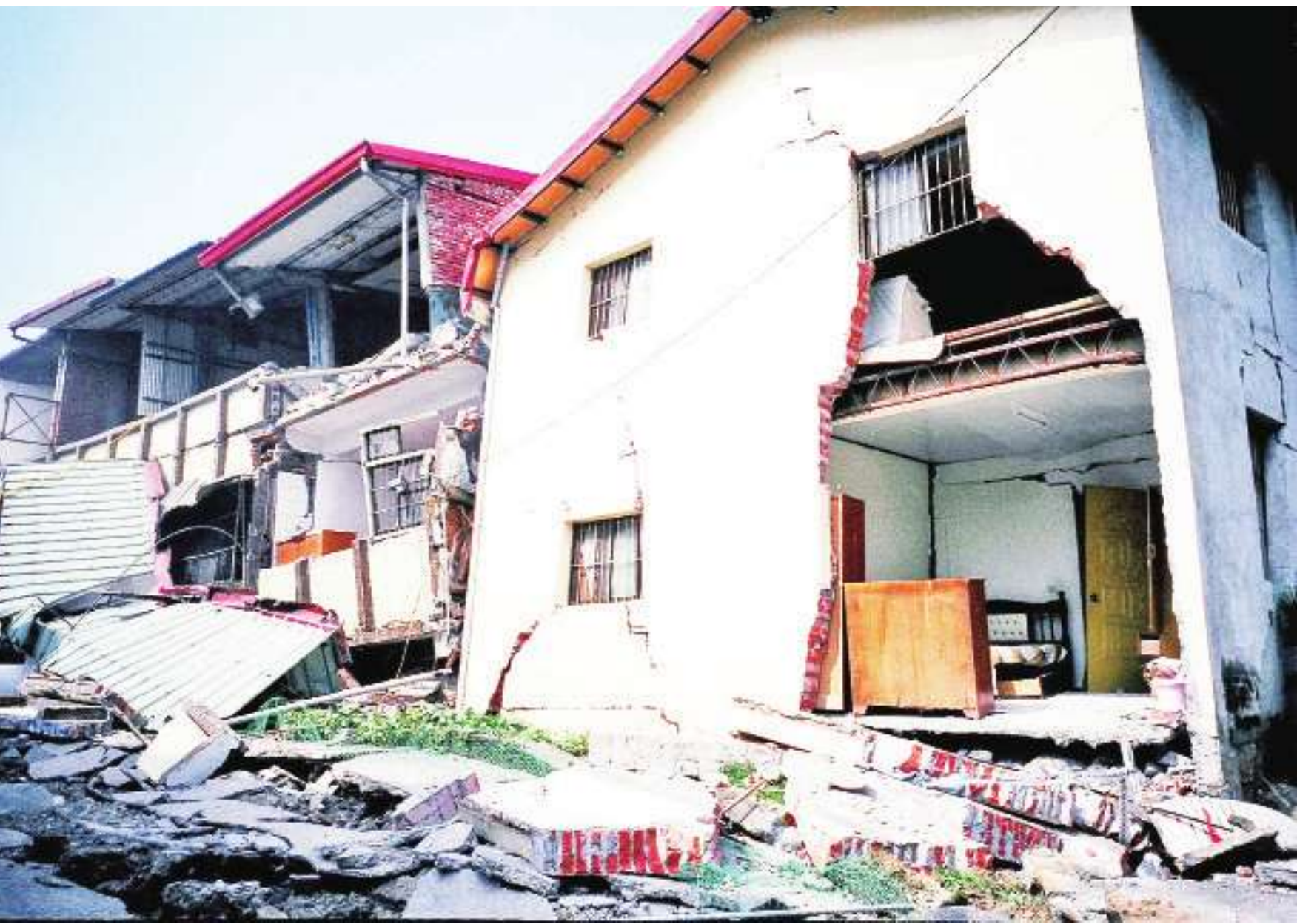
▲近期的地震是給民眾一個防災的提醒，台灣處於地震活躍帶，大地震隨時都發生。圖為南投房屋在921地震中倒塌毀損。（網路截圖）
