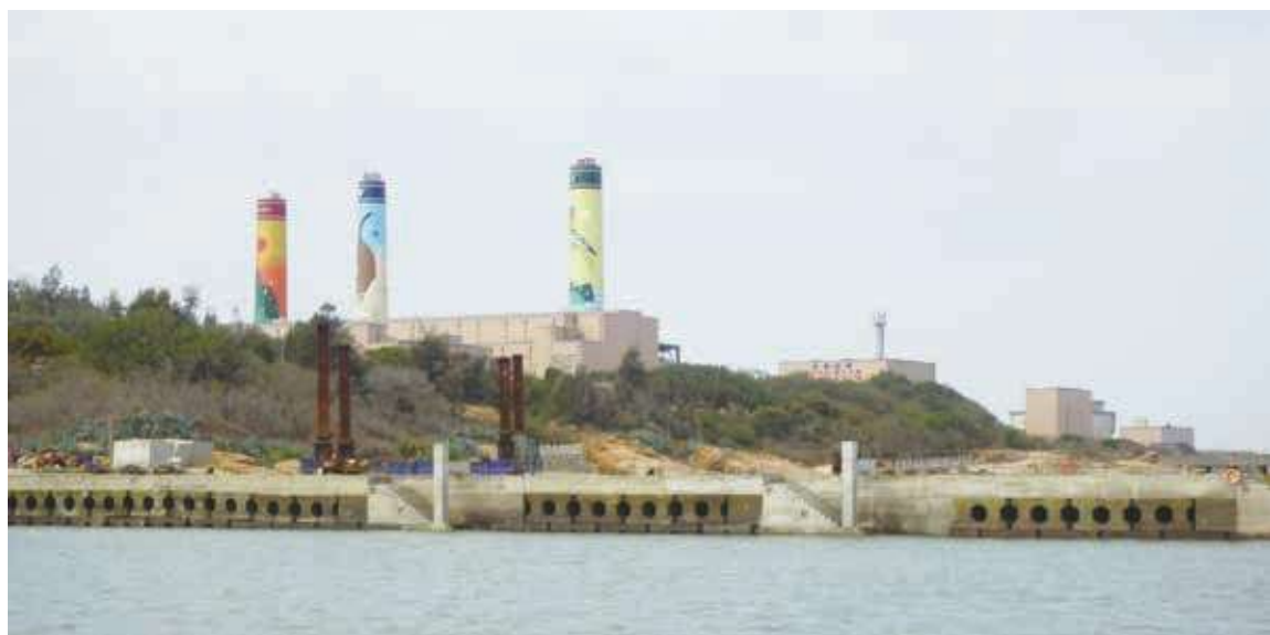
金門塔山電廠為了第 9、10 號機組，塔山電廠新增 1 座煙囪，連同原有 2 座煙囪重新彩繪，儼然成為金門新地標。(中央社)
