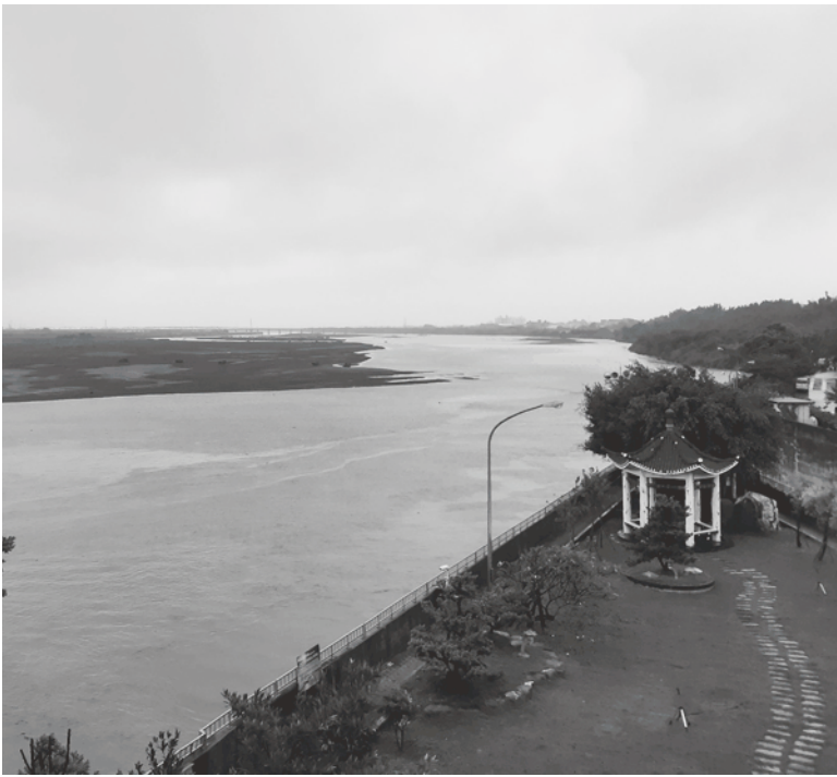
▲ 高雄市主要取水的高屏溪攔河堰因颱風「閃電」過境，川流量暴增數倍，有助於南水局供水靈活調度。
