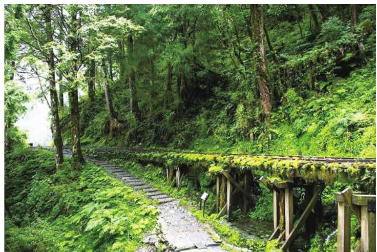
▲民眾使用現地枯倒之山櫻花枝條作為「櫻木花道」邊坡及台灣生產之柳杉疏伐木來設置土木階梯。（主辦單位提供）
