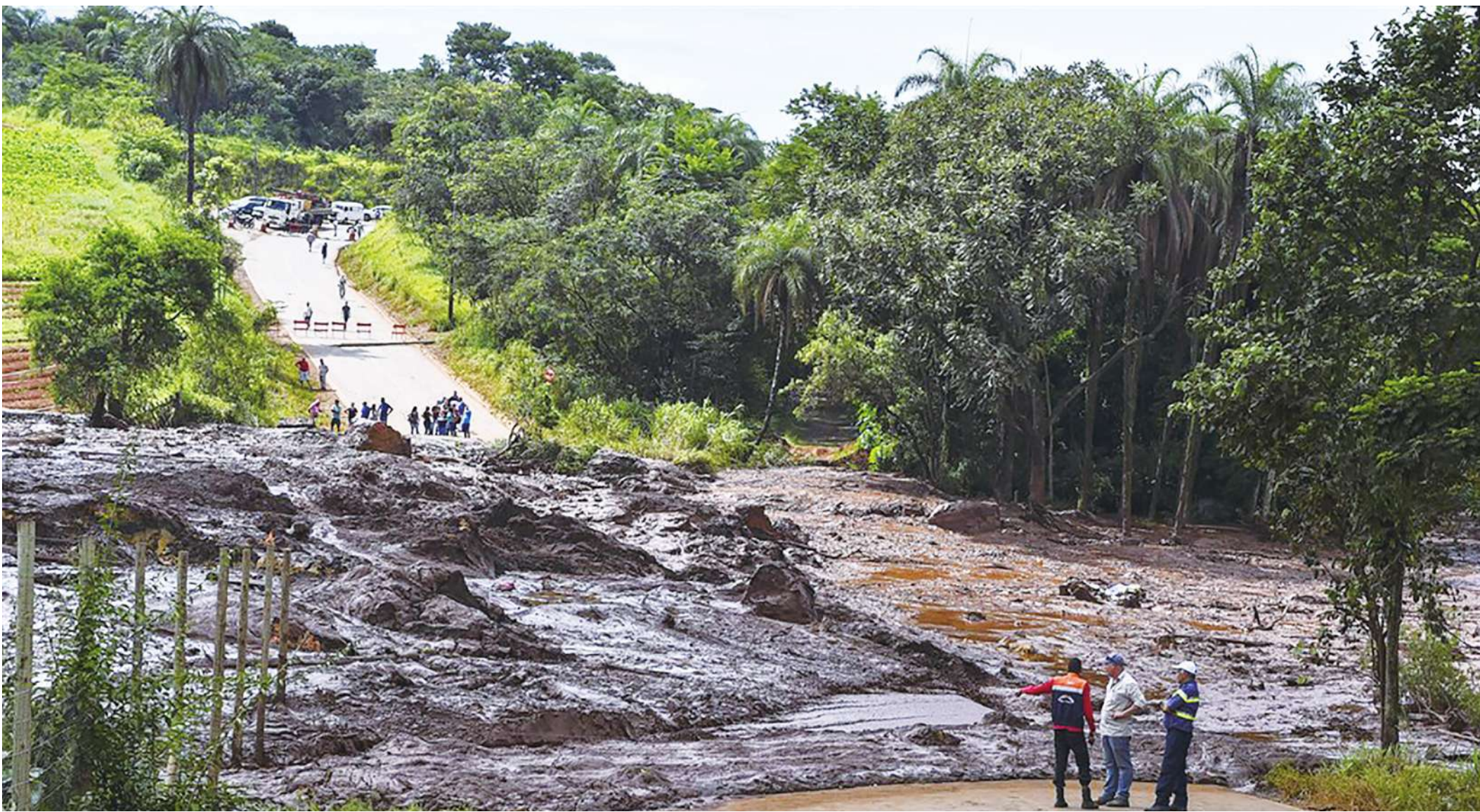
▲巴西的米納斯吉拉斯州以鐵礦出名，礦場裡一個專門存放廢礦砂的大壩，在大家毫無預警下，大壩突然潰決，整個廢礦砂夾帶著水，像是台灣的土石流一樣奔騰而下，許多礦場設備、下游的小鎮村莊被淹沒。（網路截圖）
