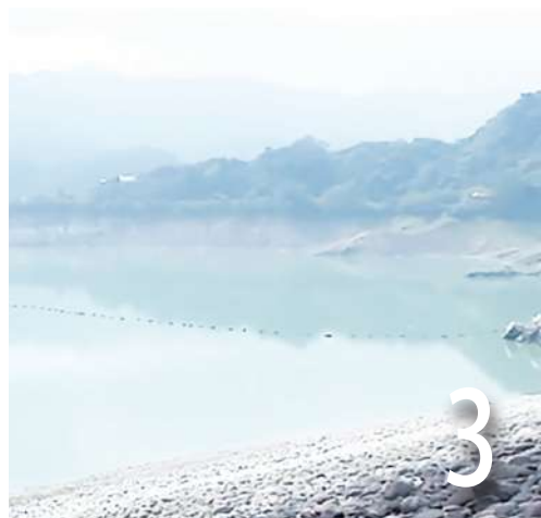
水庫還有水 稻作、產業供水無虞 水利署強調，即使梅雨量不如預期，水庫蓄水量仍陸續完成全台稻作的供灌，確保 2 個月以上的民生、產業水量。
