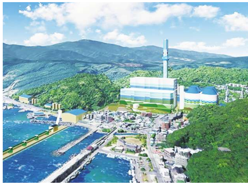
▲舊深澳燃煤發電廠已於 2007 年除役，而台電規劃在原址更新擴建，但藍委們批評與世界無煤趨勢相悖。(photo by 台電提供)
