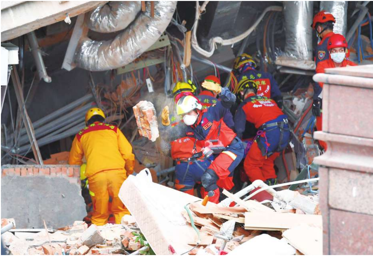
▲ 花蓮 6 日深夜發生強震，7 日救難人員徒手在倒塌的雲門翠堤大樓挖掘，找尋失蹤住戶。（中央社）
