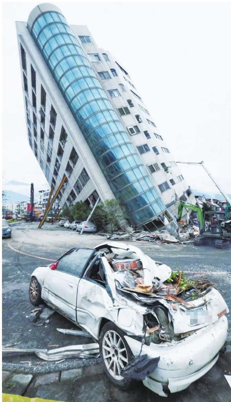
▲花蓮 6 日發生強震，雲門翠堤大樓嚴重傾斜，多名住戶下落不明，7 日持續搜救中。(中央社)
