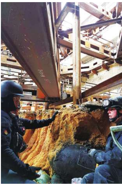
▲ 香港在一處施工地點內，一星期內兩度掘出炸彈。(photo by 香港警察 facebook 專頁)
