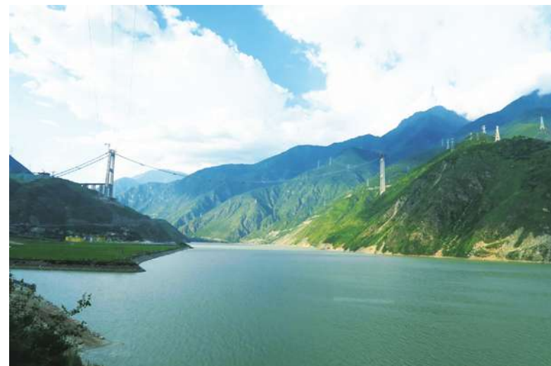
▲▲ 中國大陸四川省興建橫跨大渡河的興康大橋被譽為「川藏第一橋」。這座興建中的橋塔高 65 層樓，且所處河谷風大，拉高施工難度。（資料照片）
